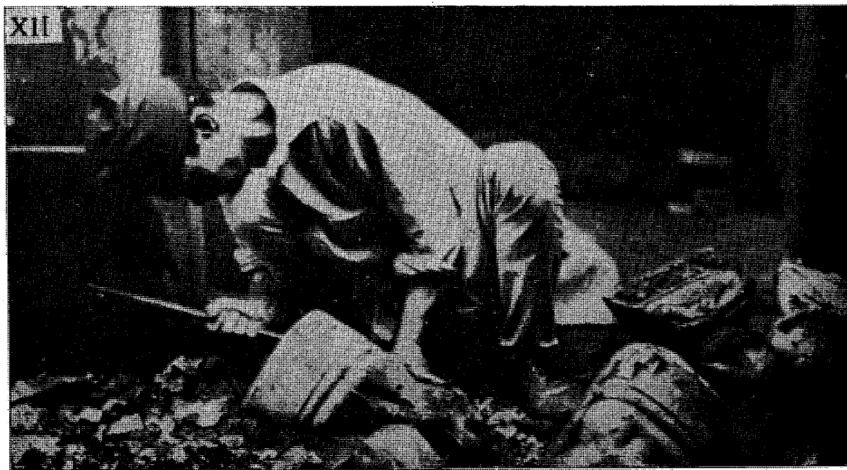
XII. L'apprenti gratte l'enduit après la fonte.
