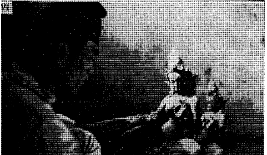
VI. Application du deuxième enduit, plus épais que le premier.
