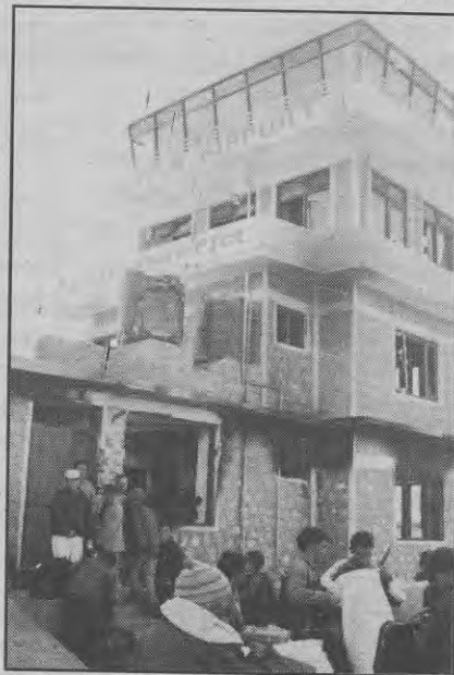
आक्रमणबाट प्वाल परेको पानी ट्यांकी र जुम्ला विमानस्थल कार्यालय/तस्वीर : गोपी बुढा
